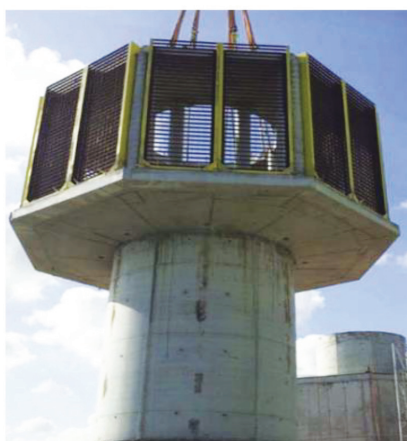
شکل ۱: برج ورودی عمودی با آشغالگیر درشت
